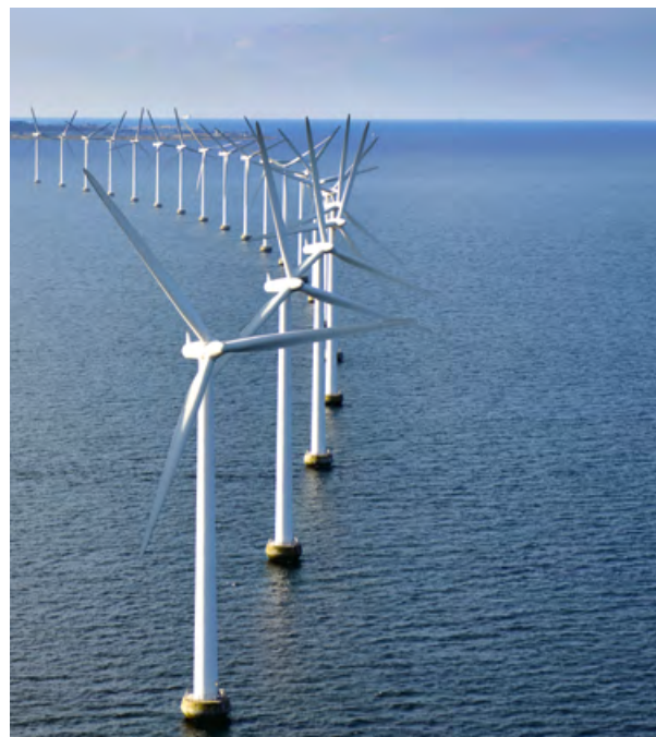
Unterwasserroboter sollen helfen, Windkraftanlagen vor Schäden zu bewahren.
